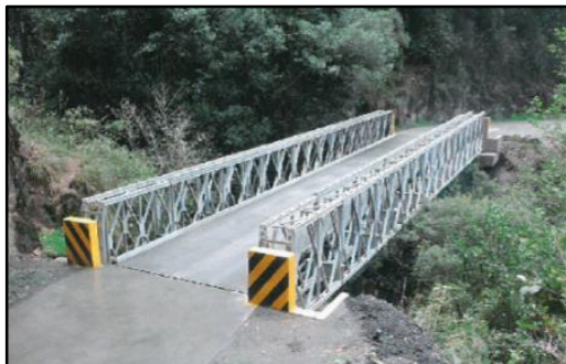
Imagen de referencia – Puente Modular Vehicular
