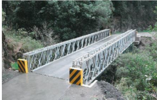
Imagen de referencia – Puente Modular Vehicular
