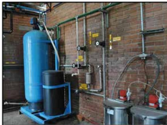
Doble cabezal dosificador de resina
