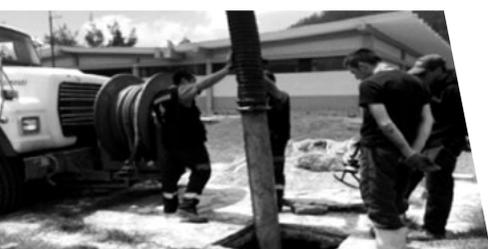
Extracción de materia orgánica mediante succión con Sistema Vector".
